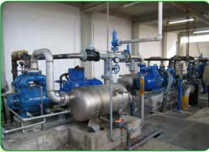
Groupes compresseurs CRVS pour la circulation de **BIOGAZ** dans le digesteur.
