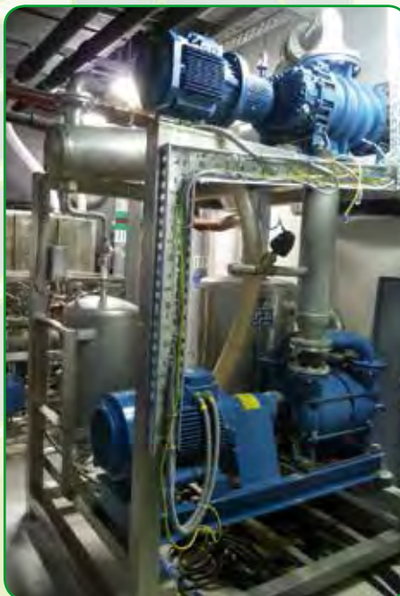
Lebensmittelindustrie: Vakuumpumpen im Einsatz in der Schälphase von Gemüse im Agroindustrie-Bereich.
